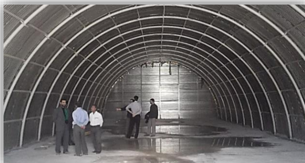
احداث کارگاه تهیه و ذخیره خوراک دام
